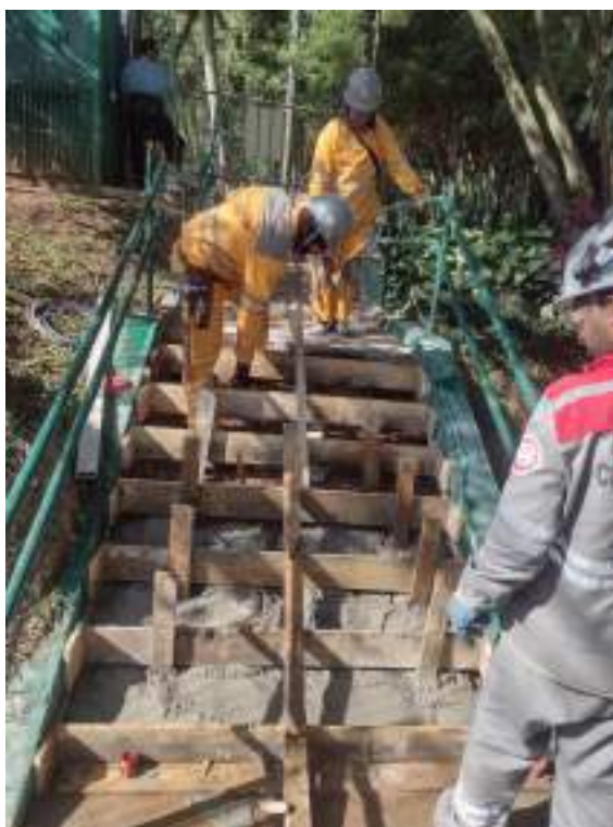
Figura 37 Manutenção escada da entrada (depois)
