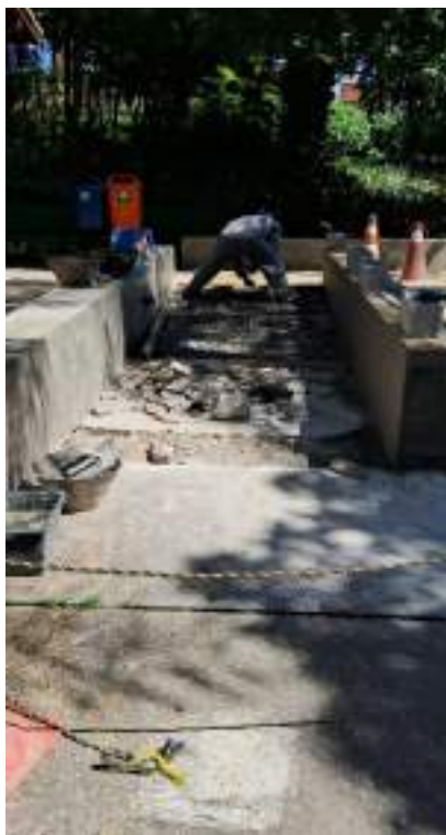
Figura 52 Construção de área plana na área de lazer (depois)
