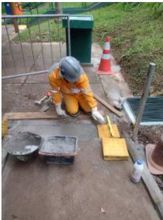
Figura 55 Instalação de piso tátil
